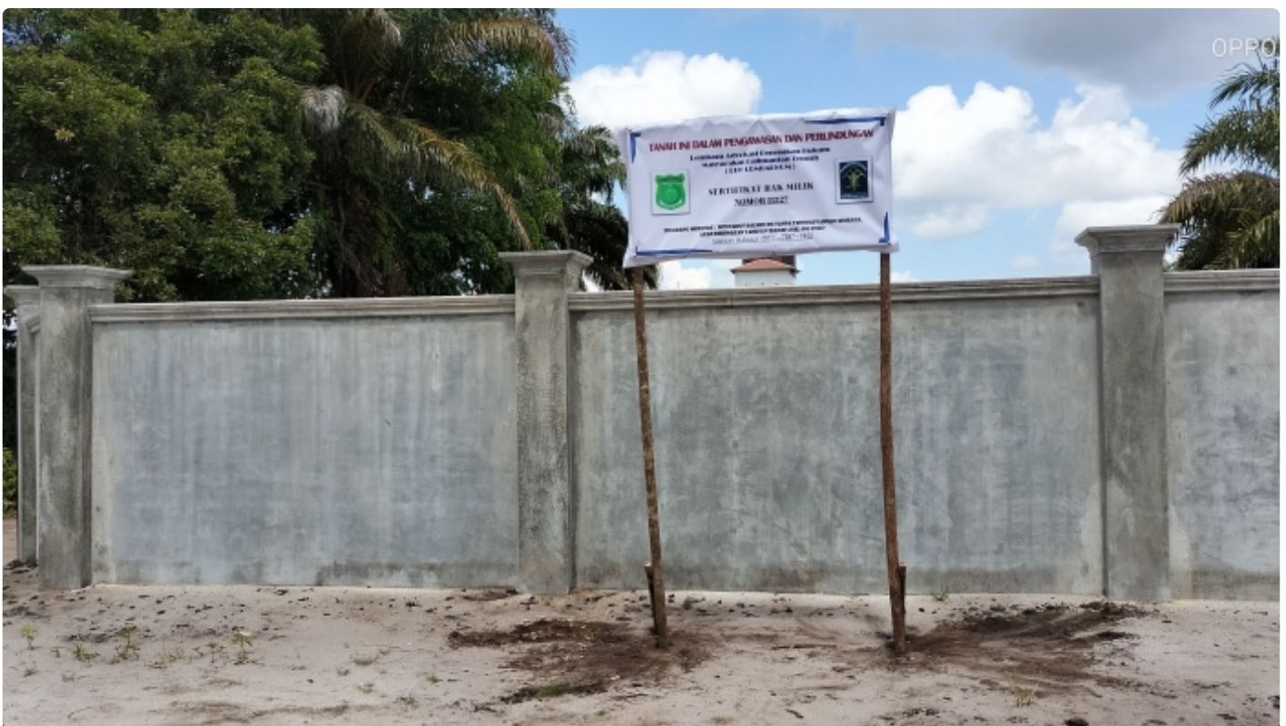
Gambar: Pagar Beton yang dibangun Oknum dengan mengambil atau mengalih punsi jalan Boreno IB
